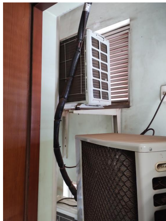
Figura 8 – Dutos Condensadora 02
