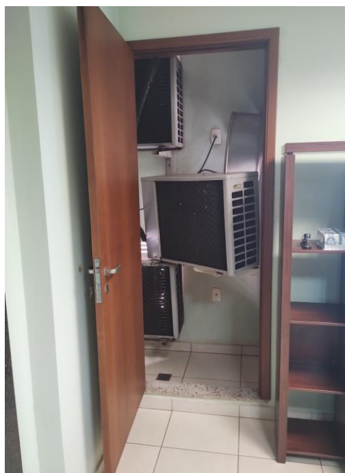
Figura 2 – Área Técnica (Local onde estão instaladas as condensadores) - Sala RC
