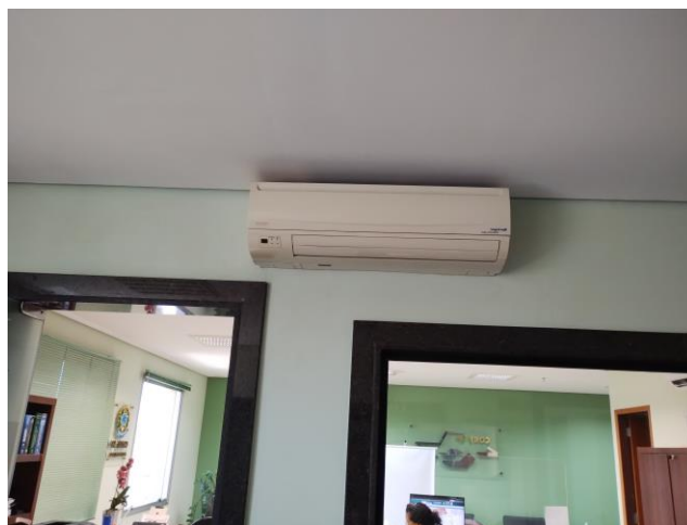
Figura 10 – Evaporadora 02 a ser substituída (Aprox. 3,0 metros distante da Área Técnica)
