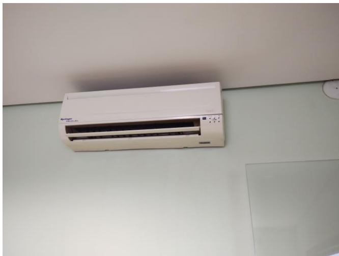
Figura 9 – Evaporadora 01 a ser substituída (Aprox. 7,0 metros de distância da Área Técnica)
