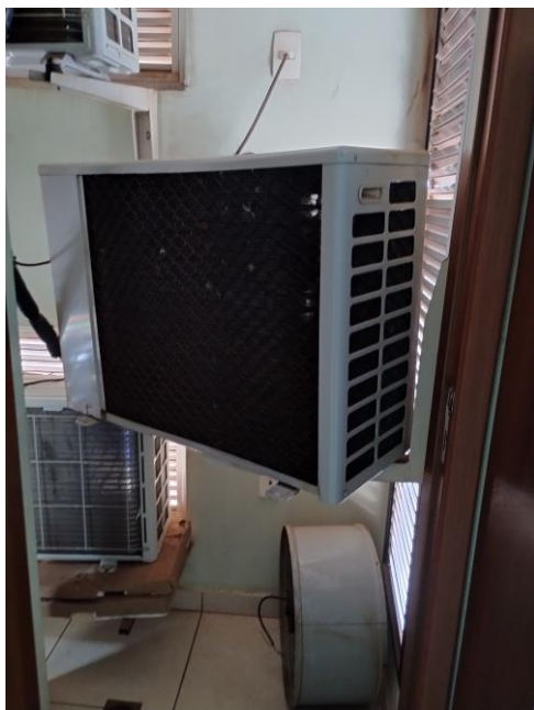
Figura 5 – Condensadora 02 a ser substituída - Vista Sala RC
