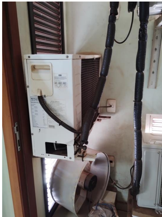
Figura 4 – Condensadora 01 a ser substituída
